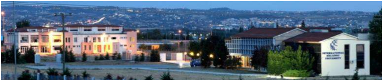
Εικόνα 1. Όψη των κτιριακών υποδομών στη Θέρμη Θεσσαλονίκης
